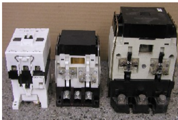
Malé vzduchové stykače různých proudových hodnot
