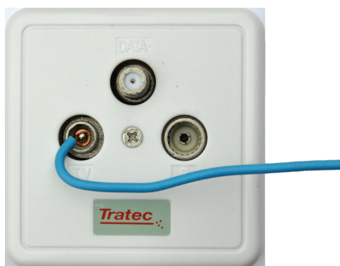
Obr. č. 96 – nevhovující připojení, kabel není uzpůsoben pro připojení k KTR Pro přenos signálu nelze použít obyčejný nestíněný drát, ani elektrikářskou dvoulinku, ani telefonní či UTP kabel.
