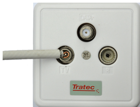
Obr. č. 96 – nevhovující připojení, kabel není uzpůsoben pro připojení k KTR Pro přenos signálu nelze použít obyčejný nestíněný drát, ani elektrikářskou dvoulinku, ani telefonní či UTP kabel.
