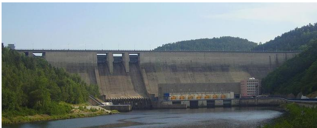
Obr. 249 - Přehradní hráz „velké“ elektrárny
