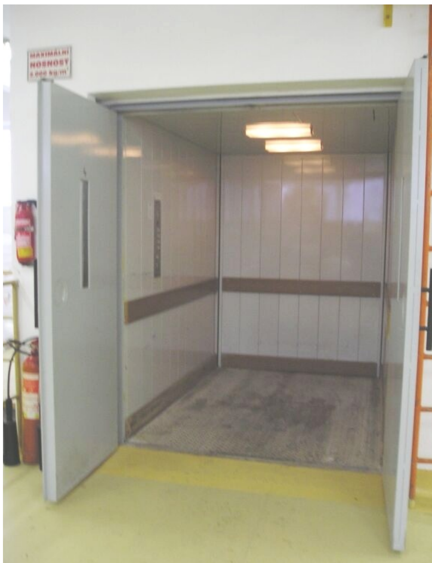
Obr. 11. Klec nákladního výtahu
