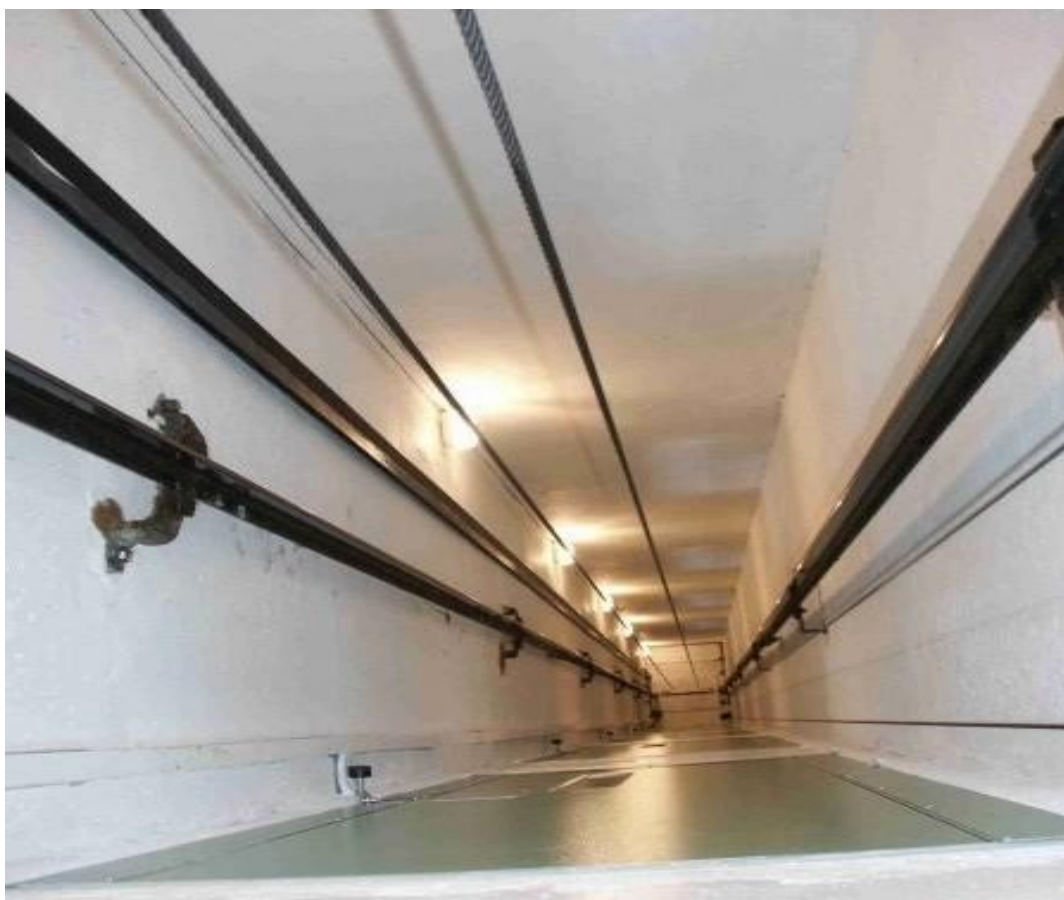
Obr. 40. Pohled do zděné výtahové šachty
