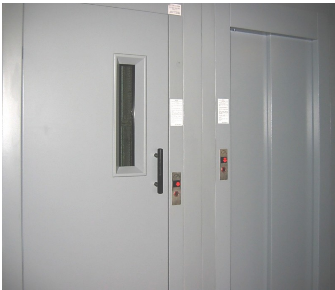
Obr. 37. Šachetní dveře (vlevo ruční, vpravo automatické)
