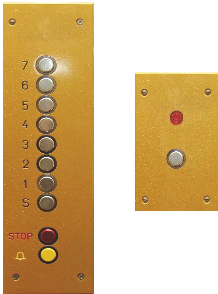
Obr. 52. Ovládací panel výtahu (vlevo tlačítková souprava v kabině, vpravo přivolávač)
