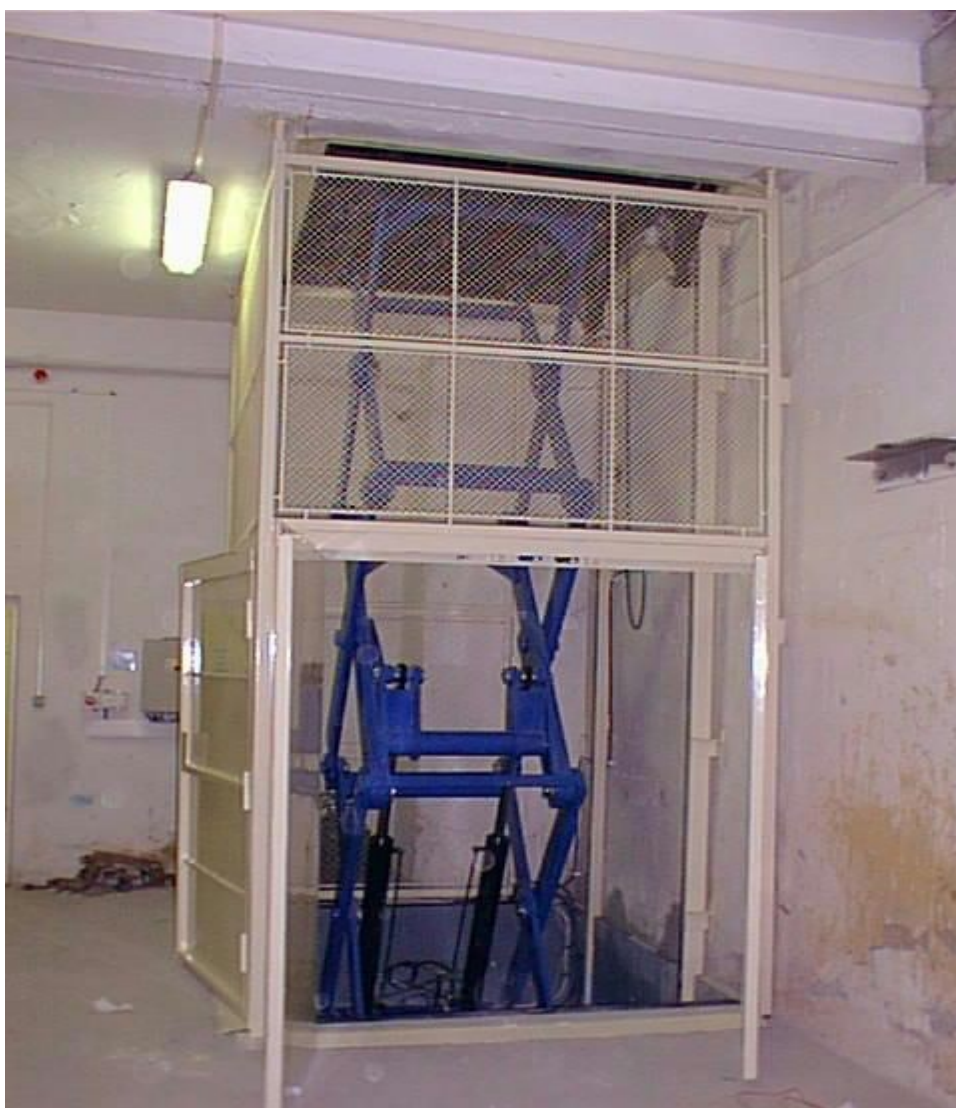
Obr. 13. Pohled do šachty stolového výtahu
