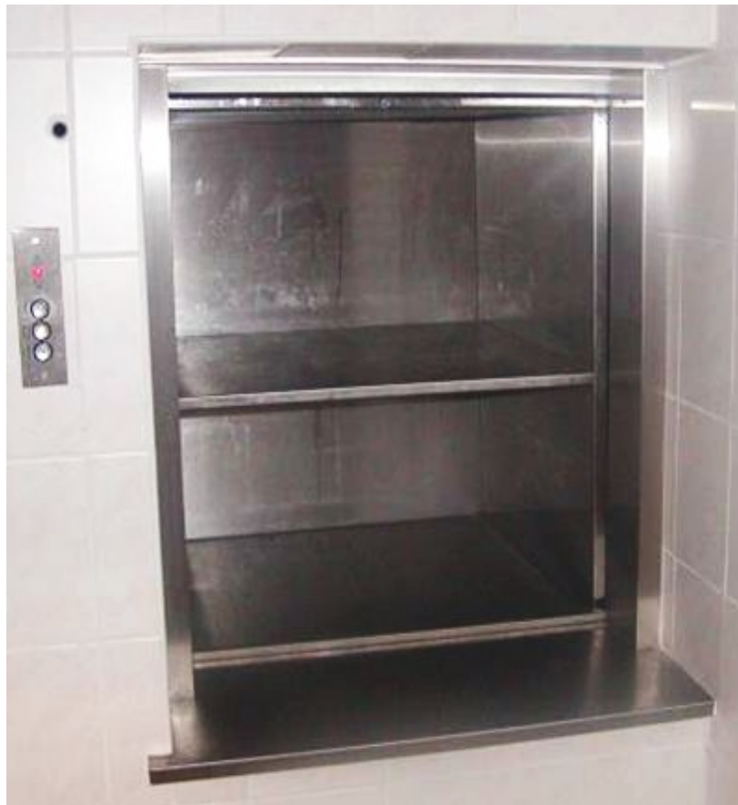
Obr. 12. Malý nákladní výtah v kuchyni
