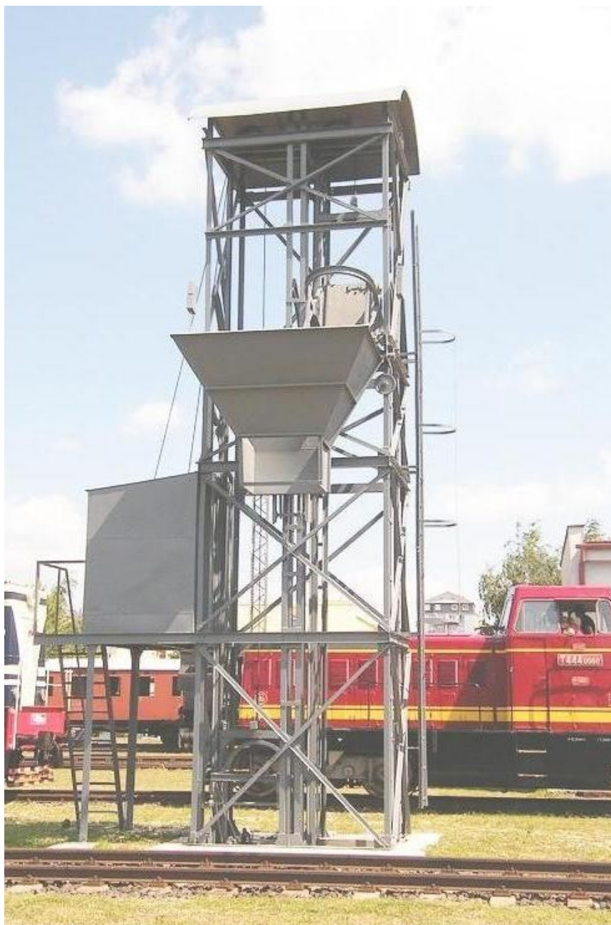
Obr. 17. Výsypný (zauhlovací) výtah na nádraží ČD
