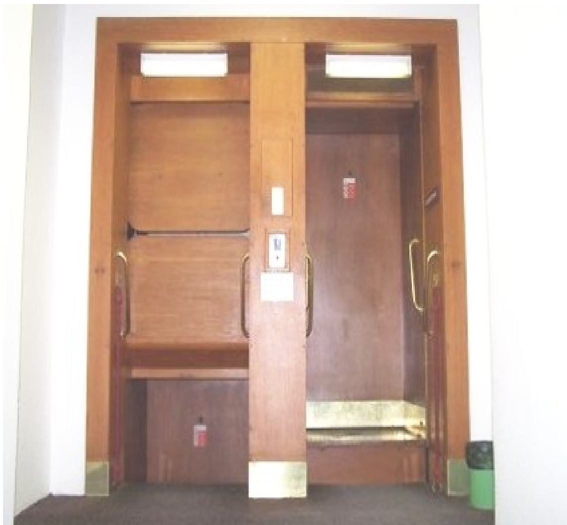
Obr. 14. Oběžný výtah – Páternoster
