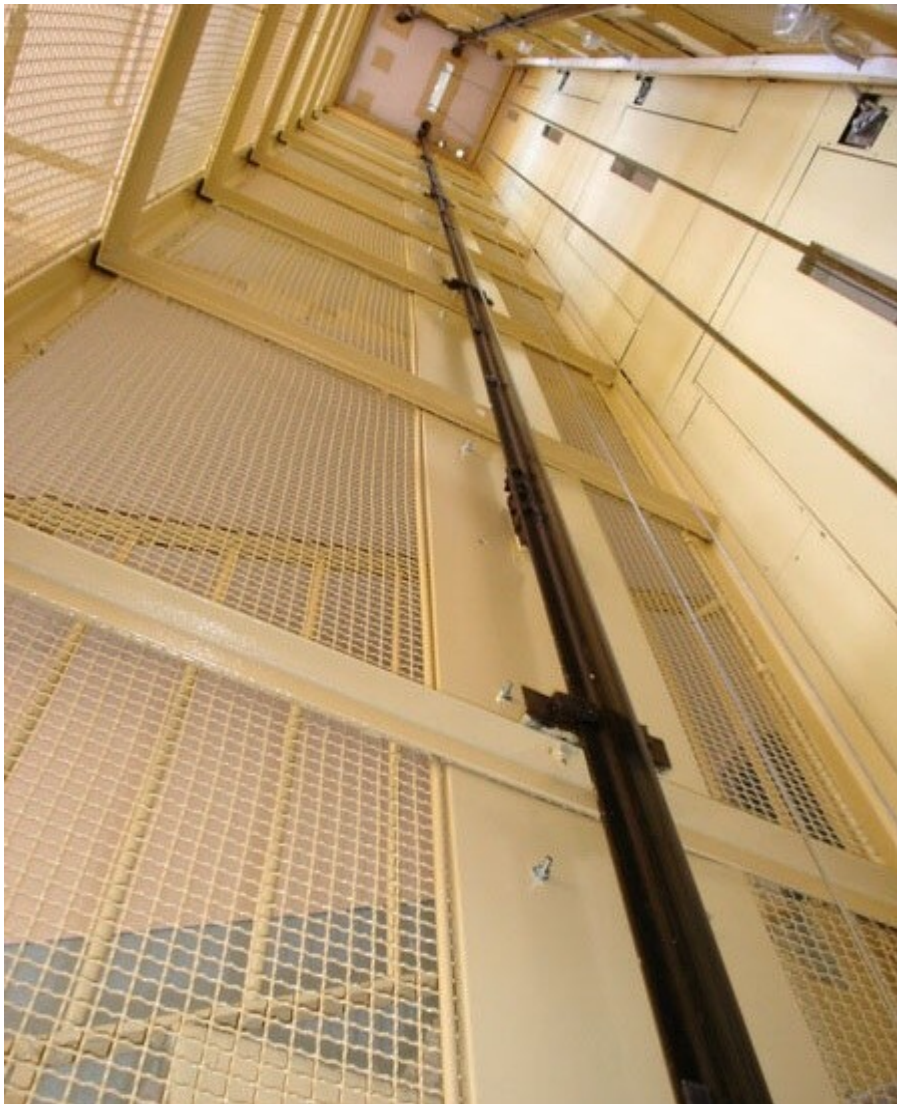
Obr. 41. Výtahová šachta umístěná ve středu schodiště (ohrazení pomocí pletiva)
