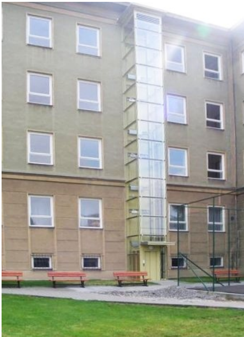
Obr. 16. Panoramatický výtah na fasádě obytného domu
