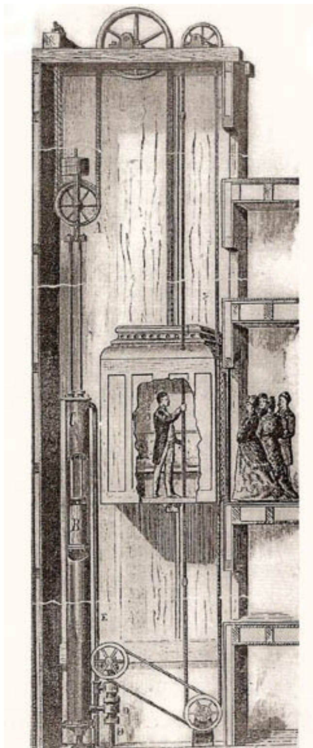
Obr. 7. Příčný řez Otisovým výtahem r. 1880
