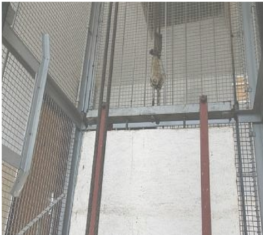
Obr. 42. Protizávaží z betonové směsi
