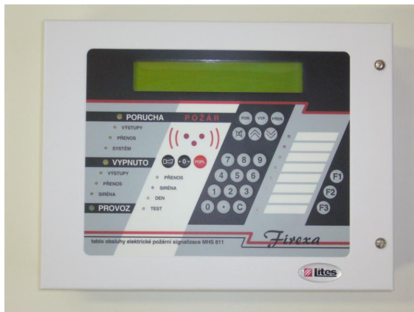
Obr. č. 15 - OPPO – obslužné pole požární ochrany
