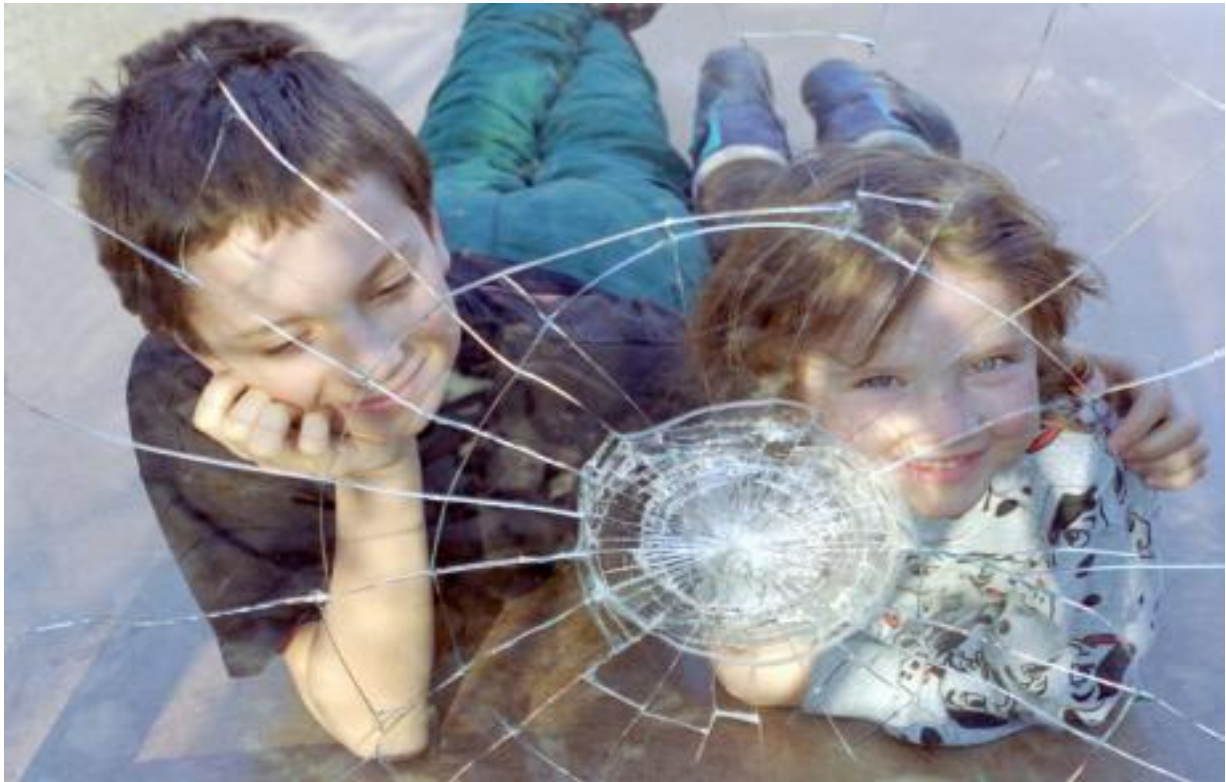
Obr. č. 8 - mechanické poškození skleněné plochy s bezpečnostní fólií
