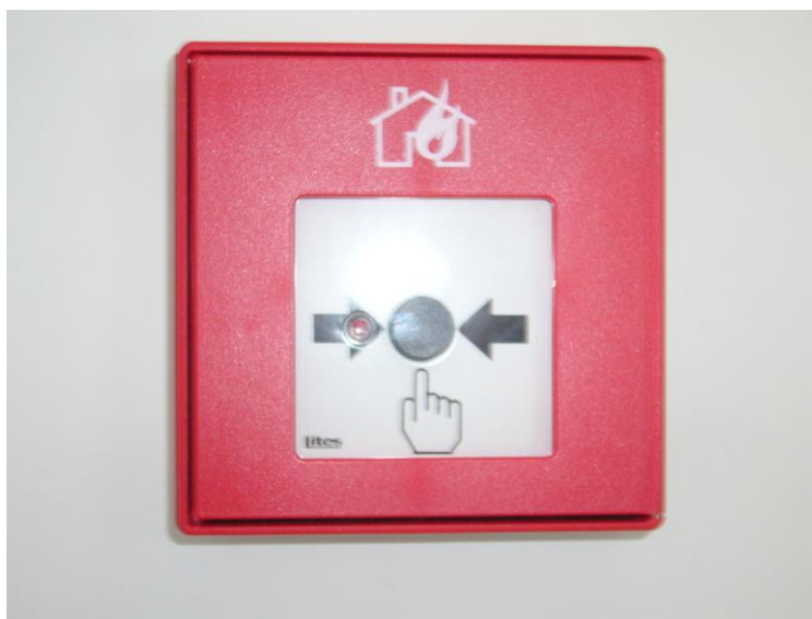
Obr. č. 1 - tlačítkový požární hlásič
