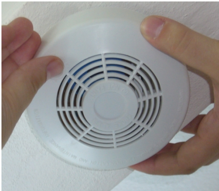
Obr. č. 70 - nasazení hlásiče do patice a provedení testu hlásiče
