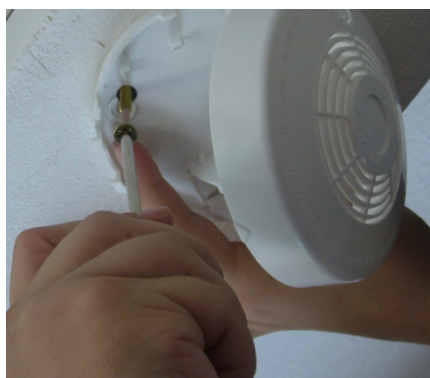
Obr. č. 68 - přišroubování patičky hlásiče pomocí šroubů
