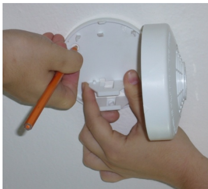
Obr. č. 65 - označení otvorů pro vrtání pomocí patice hlásiče
