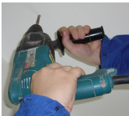
Obr. č. 66 - vyvrtání otvorů
