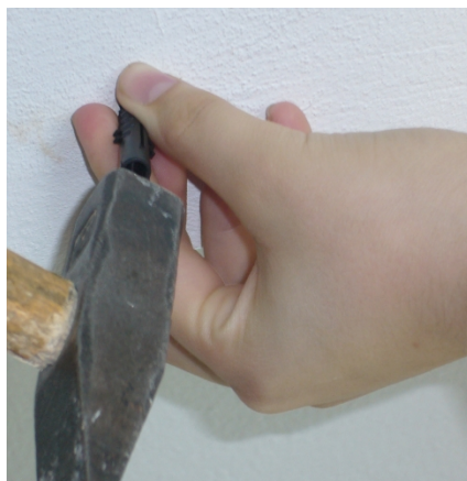
Obr. č. 67 – umístění hmoždinky do otvoru za použití kladívka
