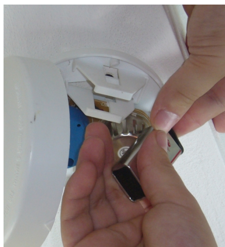
Obr. č. 69 - vložení baterii do hlásiče
