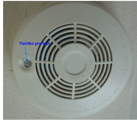
Obr. č. 70 - nasazení hlásiče do patice a provedení testu hlásiče
