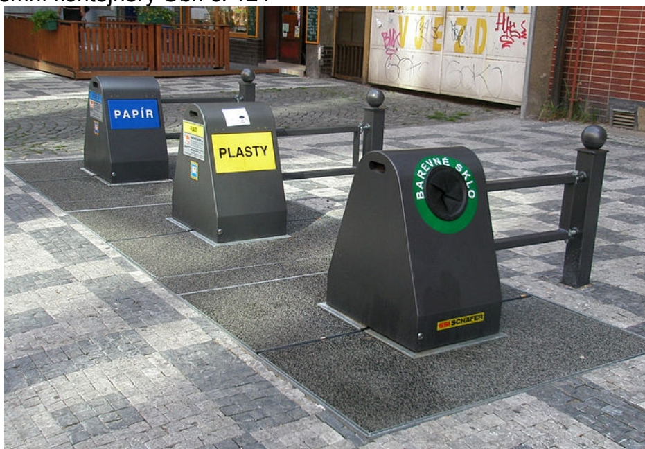
Obr. č. 124 - Podzemní kontejnery
