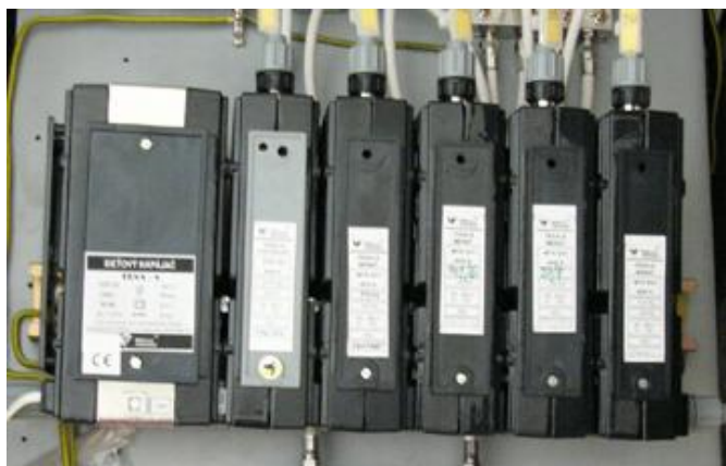
Obr. 7 – zesilovací souprava STEA-D rok výr. 1986-88. (jen pro informaci - pro DVB však vyhovují a to i kanálové konvertory STEA-D)
