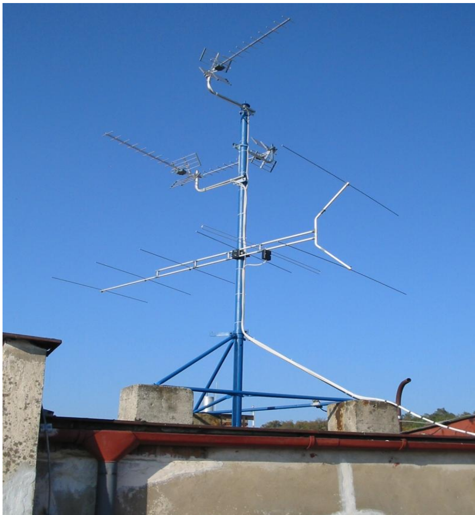
Obr. 33 - montáž trojnožky na plochou střechu (M. Valouch montáže )
