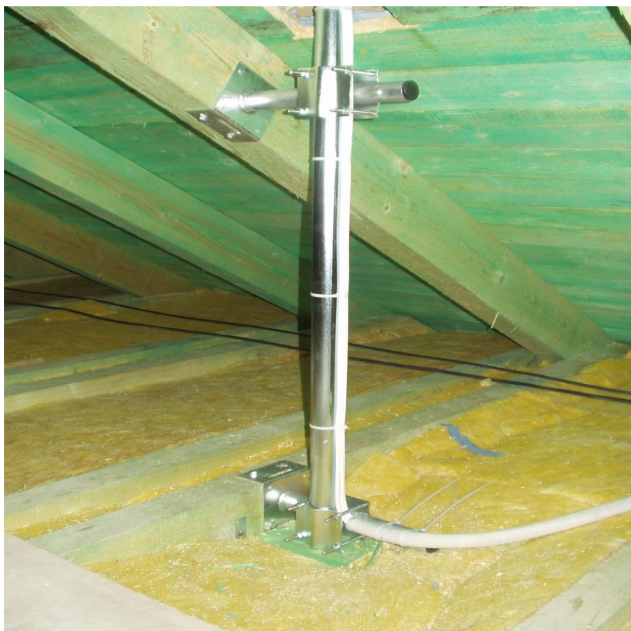
Obr. 27 - ukotvení většího stožáru k trémové konstrukci střechy pomocí stavitelných konzolí.
