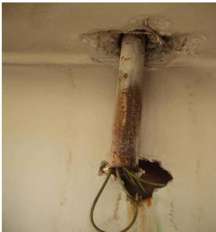
Obr. 40 – také „ukotvení“ stožáru.
