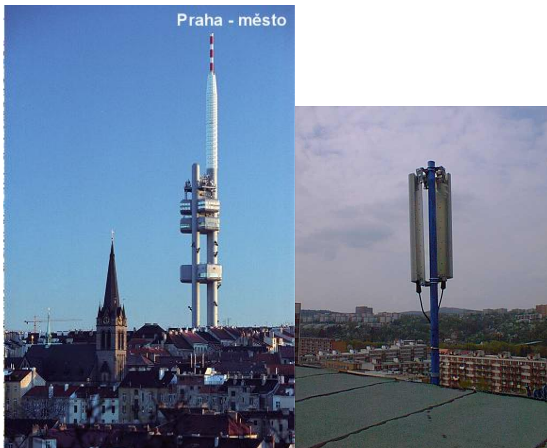
Obr. 1 – vlevo vysílač Praha-město uprostřed městské zástavby s výkonem 31,6 kW ERP, vpravo mikrovlnné GSM pojítko.
