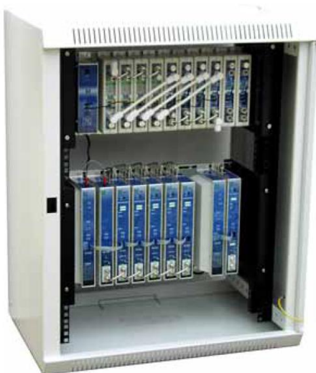
Obr. 61 – skupinové satelitní přijímače v 19“ rack skříní společně s kanálovými zesilovači a konvertory pozemního příjmu firmy Alcad.
