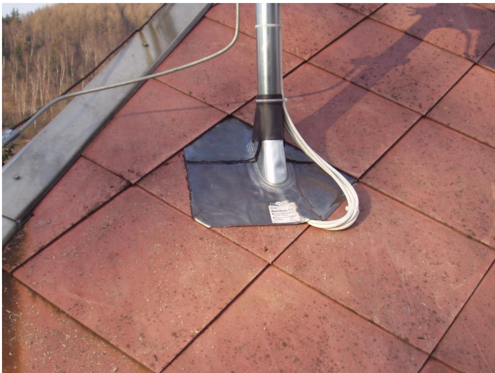
Obr. 29 - vnější vzhled s použitím olověné průchodky stožáru a gumovou manžetou. Samozřejmě je napojení na stávající bleskosvod.
