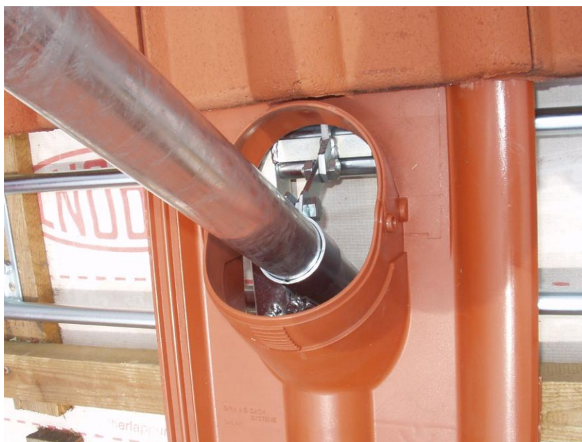
Obr. 25 – použití průchodky typu střešní tašky
