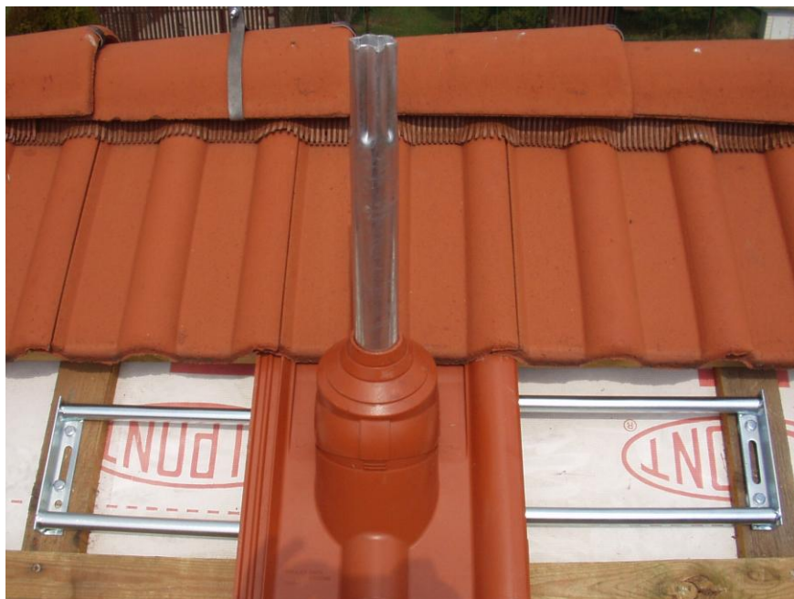
Obr. 26 – hotová montáž s nasazenou gumovou manžetou.
