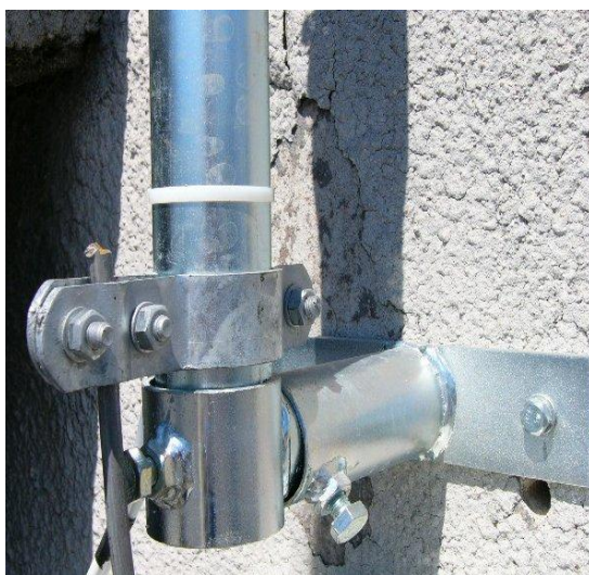
Obr. 19 - obrázek vlevo - napojení bleskosvodu ke stožáru pomocí uzemňovací objímky. Obrázek vpravo - napojení tohoto bleskosvodu ke stávajícímu svodu pomocí hromosvodářské spojky. Obě foto z montáže firmy Jikl service.
