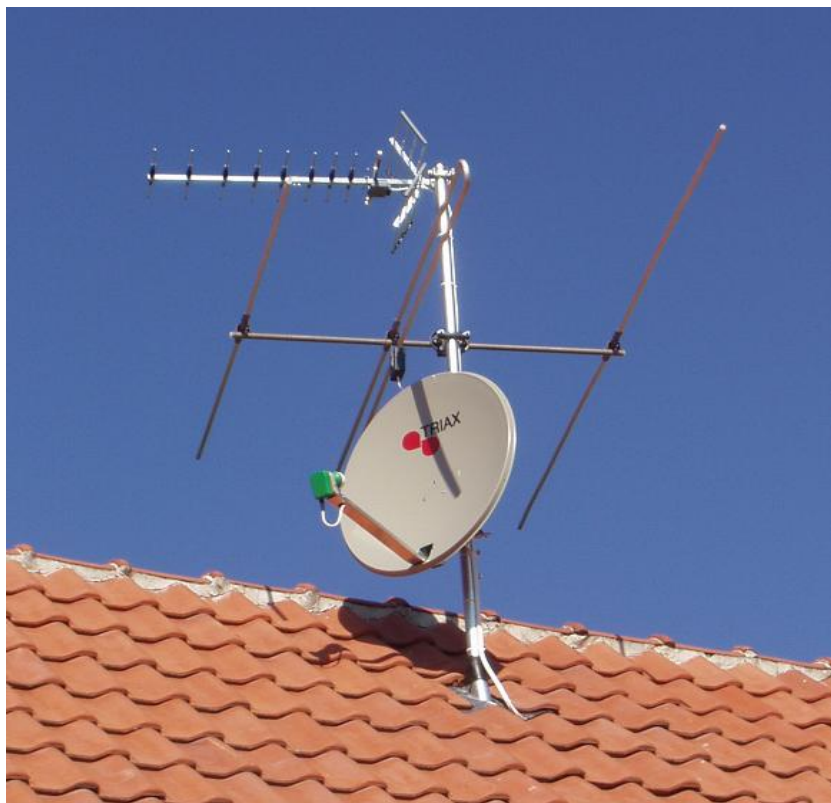
Obr. 35 - rozmístění antén při kombinaci se satelitním příjmem - nejnižše satelitní parabola, poté anténa pro VHF I+II a nad ní anténa pro pásmo UHF (SJ electronic)
