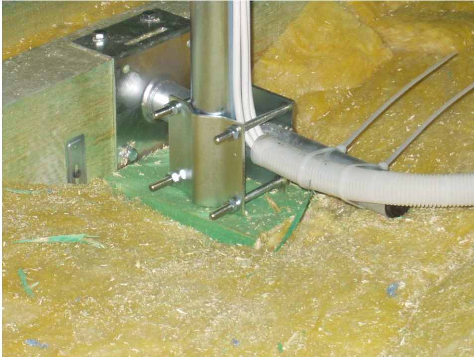
Obr. 28 - detail kotvení patky stožáru k trámu. Perfektní uložení koax. svodů do protahovacích ohebných trubek, tzv husích krků
