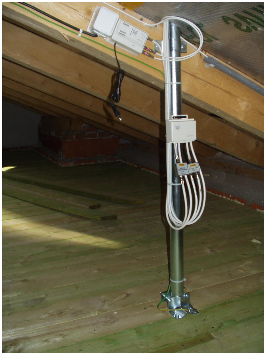
Obr. 32 - další typ kotvení stožáru k trémové konstrukci střeby. V horní části užito kotvy typu vlnka s přitažením k trému, spodní část uchycena k podlaze pomocí patky. Vidět je i přivedení ochranného vodiče pro připojení stožáru do soustavy hl. pospojování.
