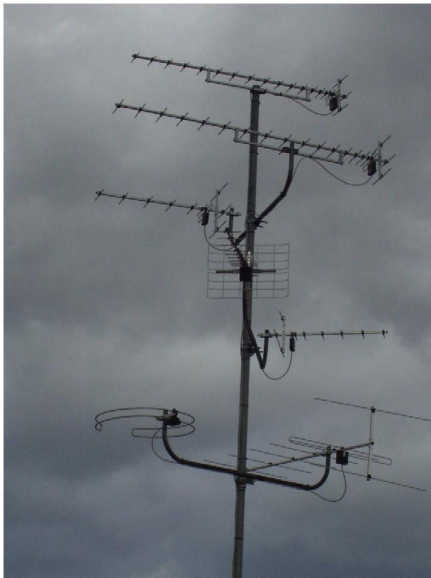
Obr. 37 - ukázka obsazenosti stožáru s větším počtem antén pro příjem z více směrů.
