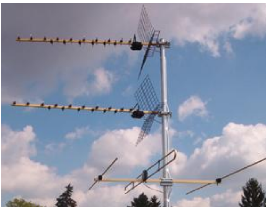
Obr. 36 - montáž jedné antény pro pásmo VHF I+II a nad ní dvou antén UHF s připevňovacím třmenem za reflektorem bez nutnosti použití výložných ráhien (Hofisat)
