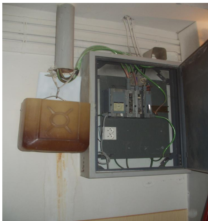
Obr. 41 – „vyřešené“ zatékání vody stožárem.
