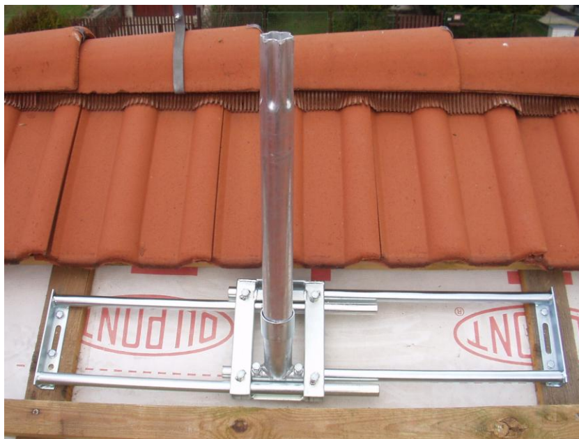
Obr. 24 – ukotvení malého stožáru mezi trámy.
