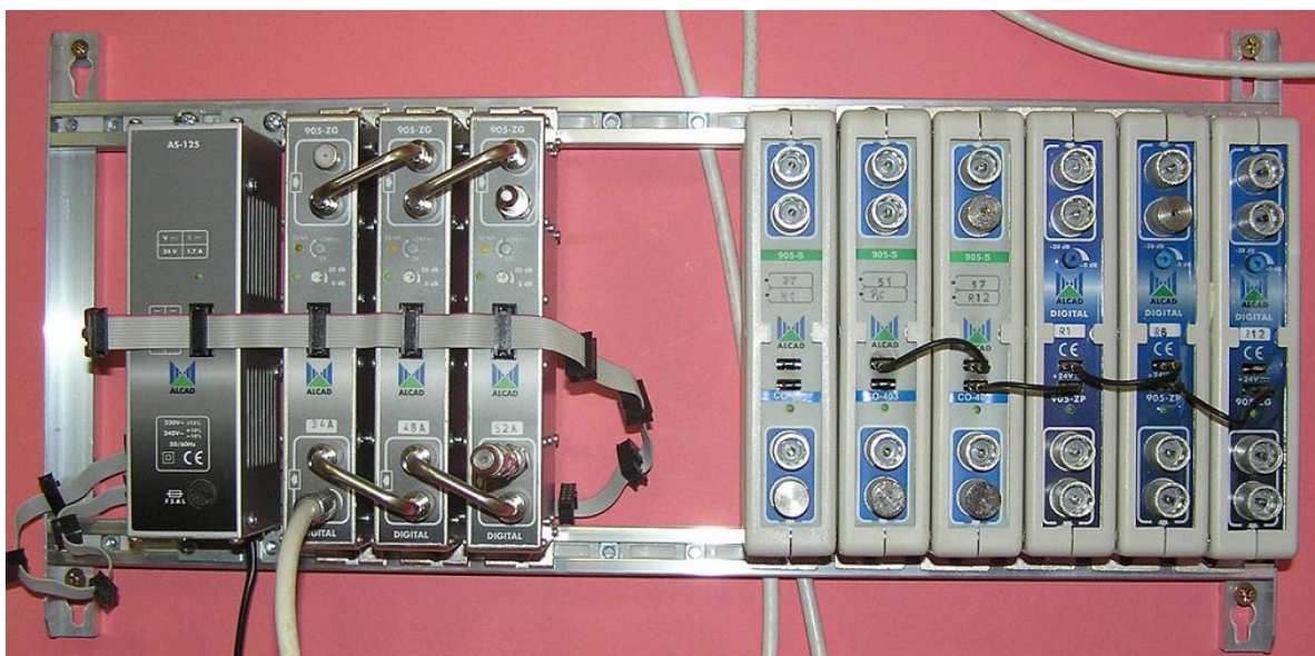
Obr. 8 – vlevo kanálové zesilovače nové řady 905ZG, vpravo kanálové zesilovače a měniče starší řady 905ZP.
