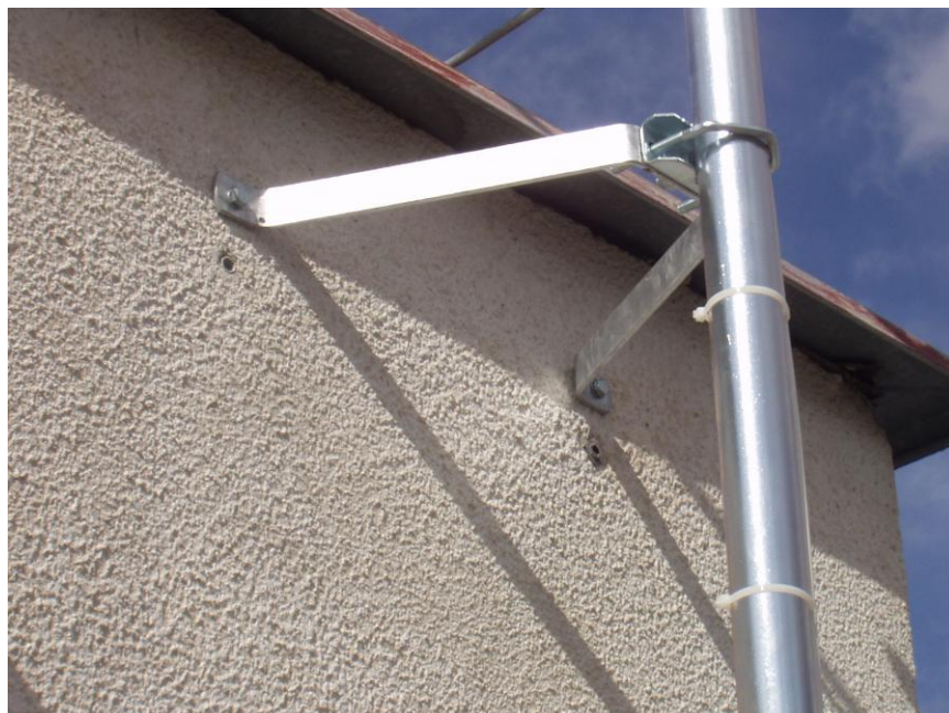
Obr. 30 - kotvení stožáru na stěnu strojovny pomocí A konzole. V horní části obrázku je vidět napojení na bleskosvod.
