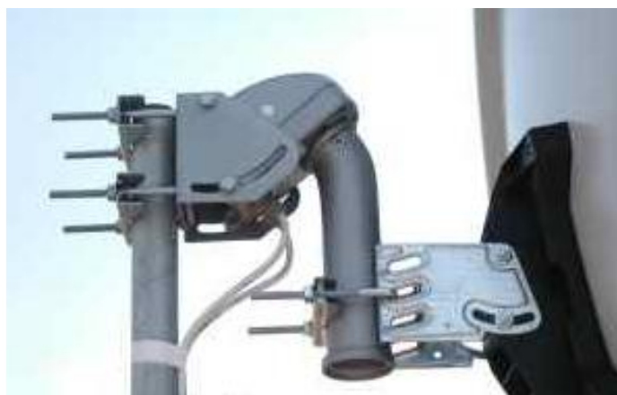
Obr. 40 - detail hotové montáže DiSEqC motoru a parabolické antény.
