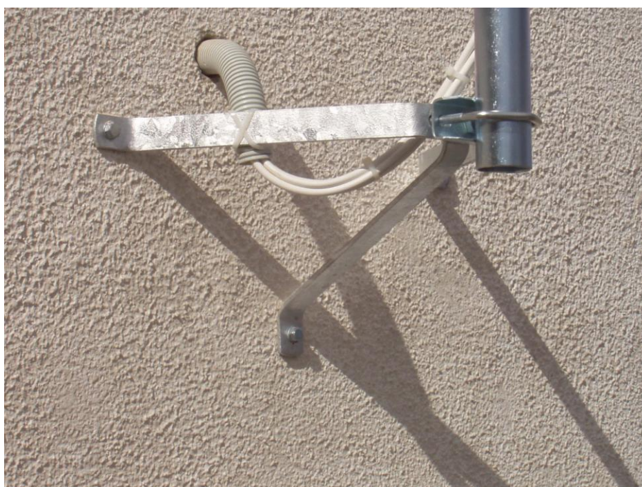
Obr. 31 - uchycení spodní části pomocí trojnožky, vstup koaxiálních svodů do objektu pomocí ohebných husích krků s odkapovou smyčkou (prověsem) na svodech.
