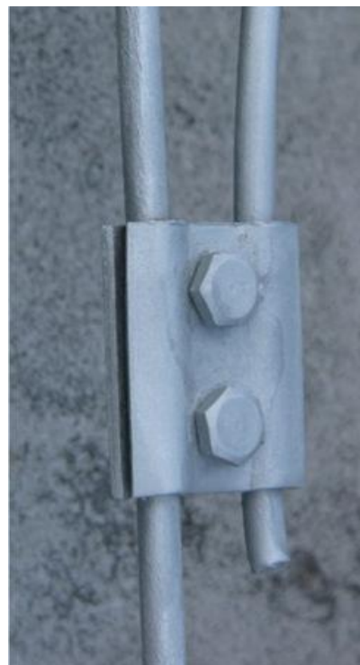
Obr. 19 - obrázek vlevo - napojení bleskosvodu ke stožáru pomocí uzemňovací objímky. Obrázek vpravo - napojení tohoto bleskosvodu ke stávajícímu svodu pomocí hromosvodářské spojky. Obě foto z montáže firmy Jikl service.
