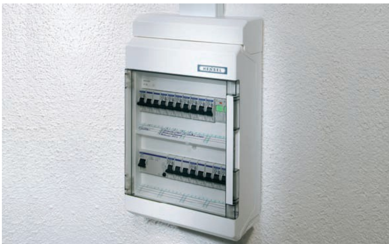
Obr.17: osazená plastová rozvodnice (zřetelně jsou vidět jističe a přepět'ové ochrany v horní řadě a proudový chránič s jističi ve spodní řadě)
